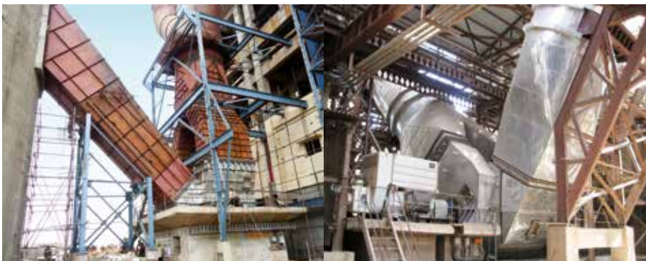
KILN FILTER FAN KILN BAGHOUSE FAN
