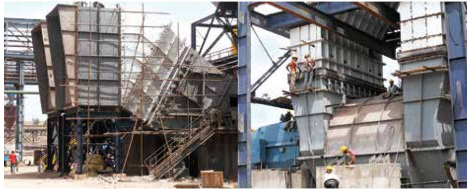
COOLING AIR FAN HOOD EXHAUST FAN
